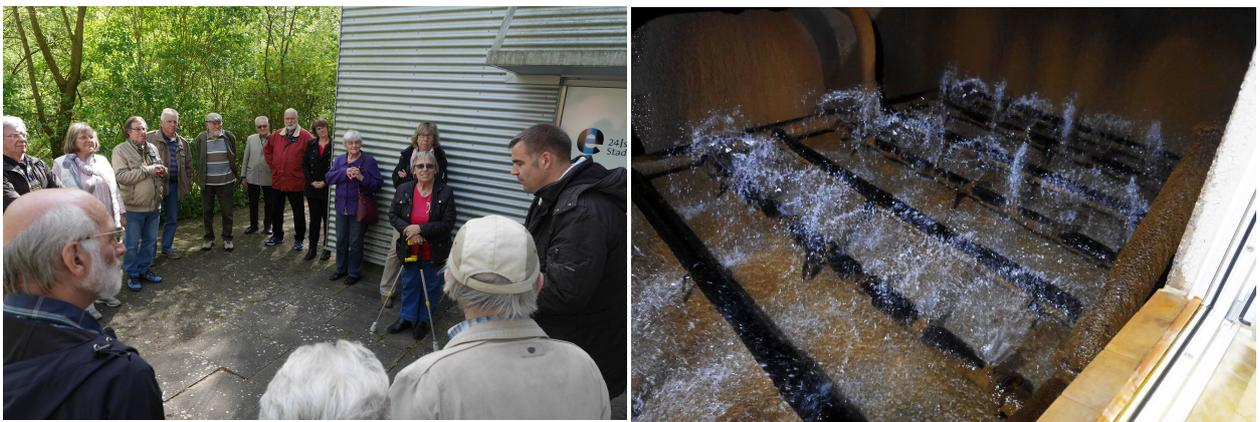
Als zweitgrößtes Wasserwerk der Stadtwerke Kiel fördert Schwentintal täglich ca. 16.000 m<sup>3</sup>. Das geförderte Wasser wird mit Sauerstoff angereichert und durchläuft 2,5 Meter Tiefe Filter, bevor es im Frischwassertank gesammelt wird. Beeindruckend war auch das Maschinenhaus mit den neuen und alten Pumpen.
